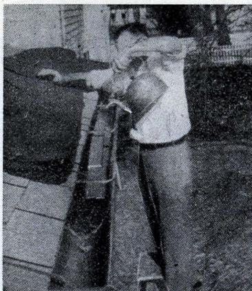
Le grondaie otturate con un poco di terra costituiscono un'eccellente vasca per inumidire le strisce di lunghezza notevole. Per mantenere calda l'acqua si possono coprire.
